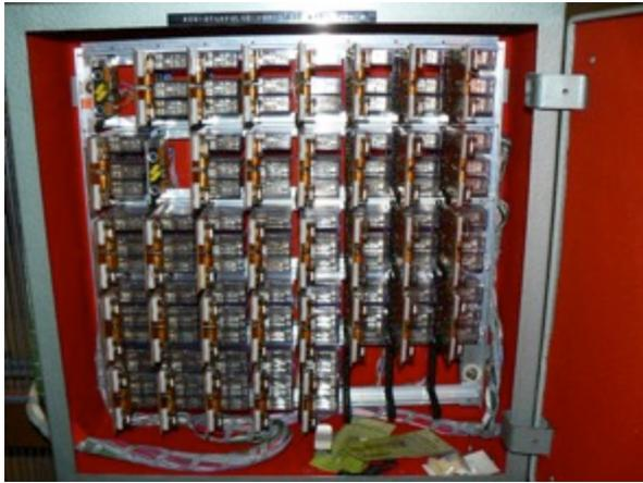
Figure 12. Les commandes électriques des registres. La commande des jeux est entièrement électrique de même que les différents accouplements et les jeux préparés. Ceux-ci sont commandés manuellement par des dominos basculants et des leviers ; aux pieds les commandes se font par des interrupteurs « champignons ».
